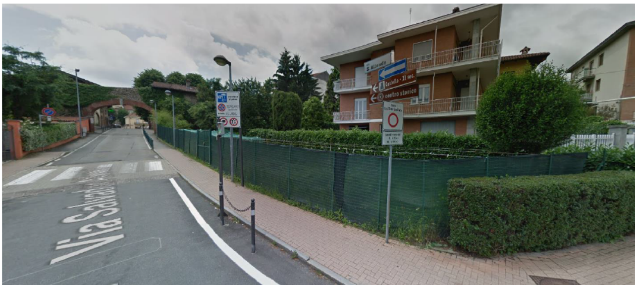
Figura 4.4.4/2. Immagine dell'area oggetto di intervento da Via Salvador Allende. Fonte: Google Maps
